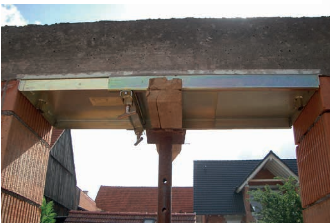
Coffrage de linteau
