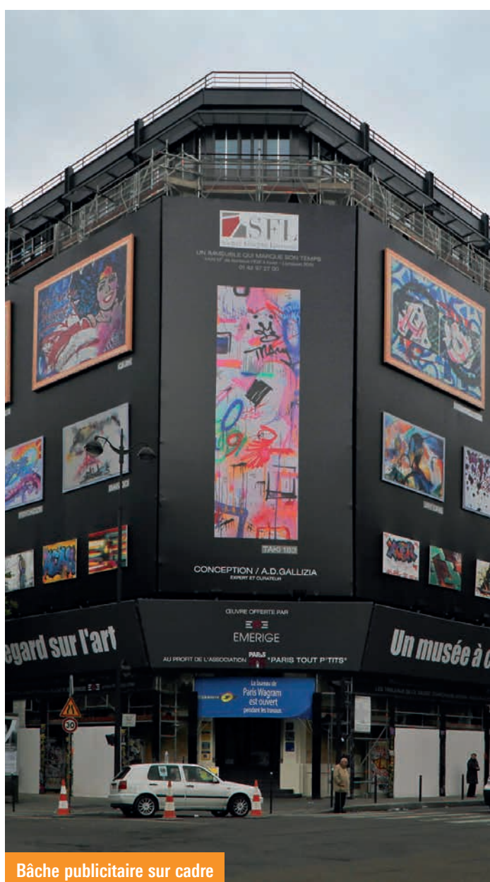
Protection de chantier par Protect System
