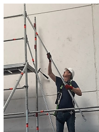
Insérer les 2 lisses dans les clips fermés
