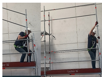
Emboîter le montant sur la structure Le garde-corps est posé.
