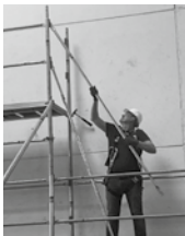
Insérer les 2 lisses dans les clips fermés
