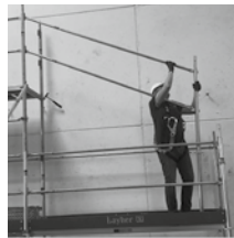
Faire glisser les lisses dans votre main, les fixer sur le montant opposé et fermer les clips
