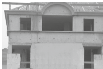
Exemple façade ouverte avec 30% d'ouverture
