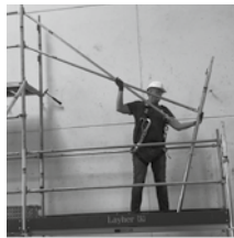
Faire glisser les lisses dans votre main, les fixer sur le montant opposé et fermer les clips
